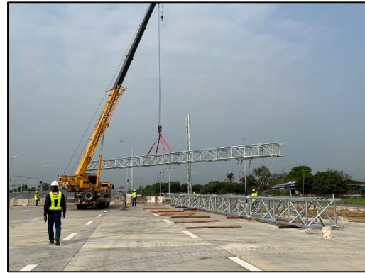
การติดตั้ง Gantry (งานระบบ)
