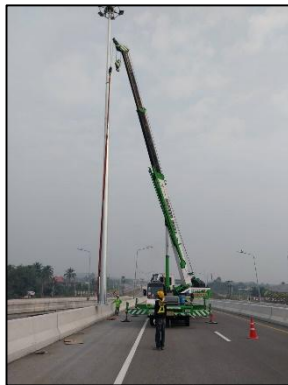
การติดตั้งไฟฟ้าส่องสว่างแบบ High mast (งานระบบ)
