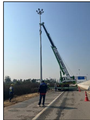
การติดตั้งไฟฟ้าส่องสว่างแบบ High mast (งานระบบ)
