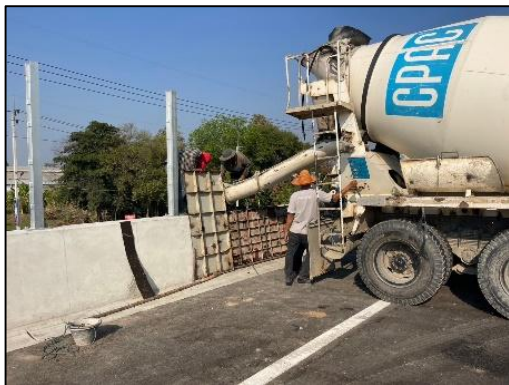
การเทคอนกรีตกำแพง Concrete Barrier กม.41+175 (โครงการฯ ตอน 12)
