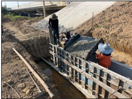
การก่อสร้าง Side Ditch Lining กม.41+100 (โครงการฯ ตอน 12)
