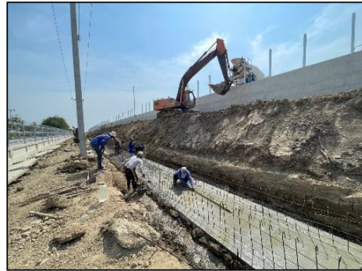
การก่อสร้าง Side Ditch Lining กม.41+100 (โครงการฯ ตอน 12)
